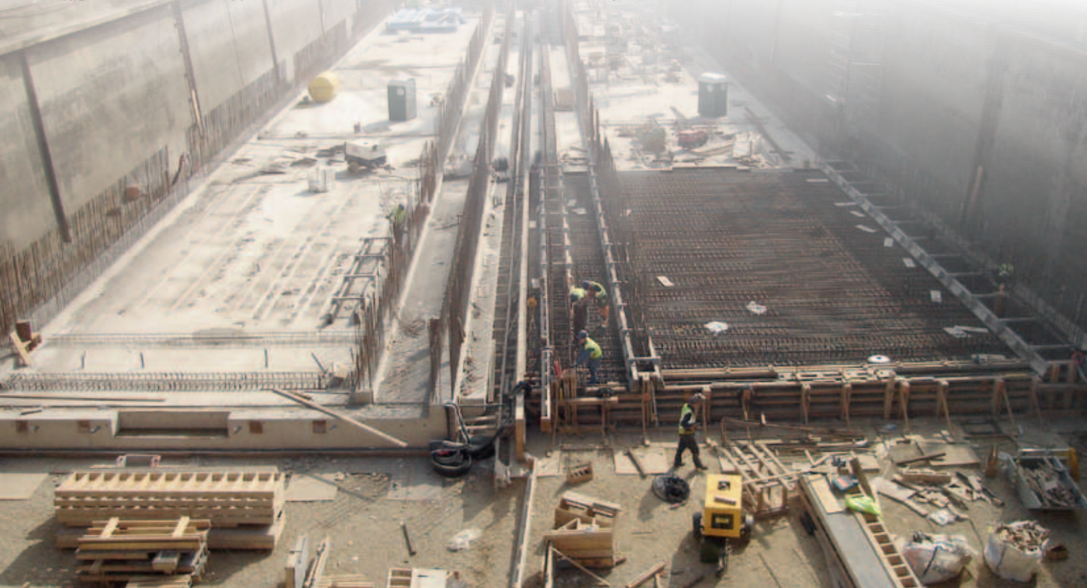
Bouwdok Tyne-tunnel, Groot-Brittannië
